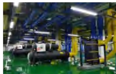
其中，机组专为 12-20℃ 出水“小压比”工况设计的三元闭式叶轮，避免了在此工况下吸气流量变化造成的制冷效率的衰减。
